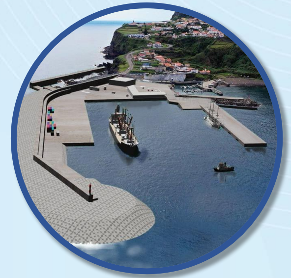
Reconstrução do porto das Lages das Flores
