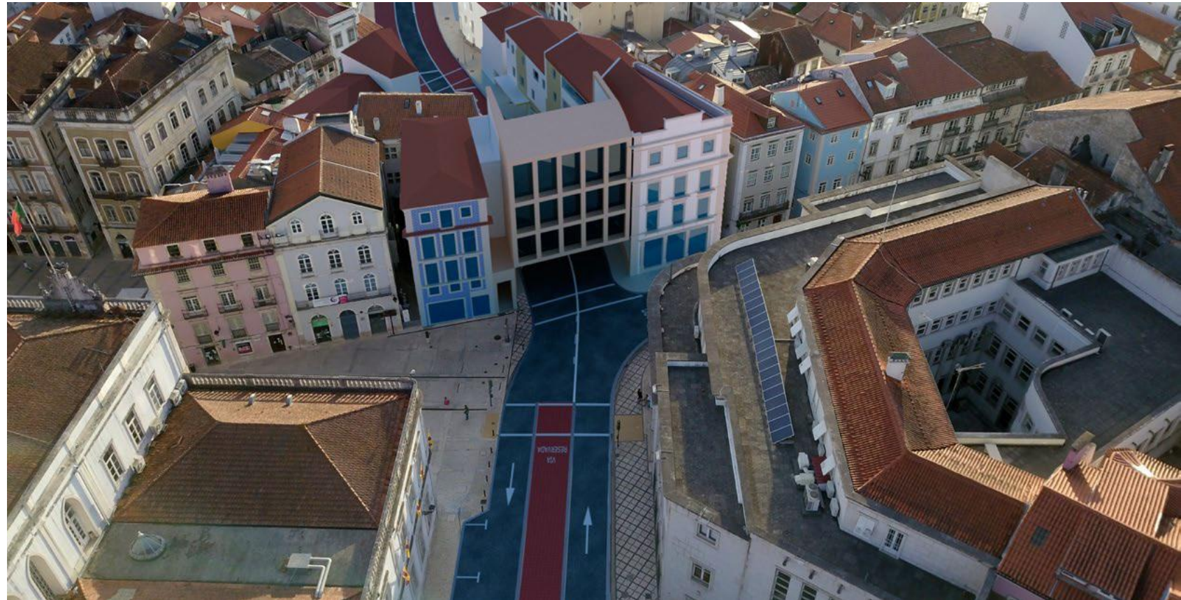
Edifícios da Via Central
