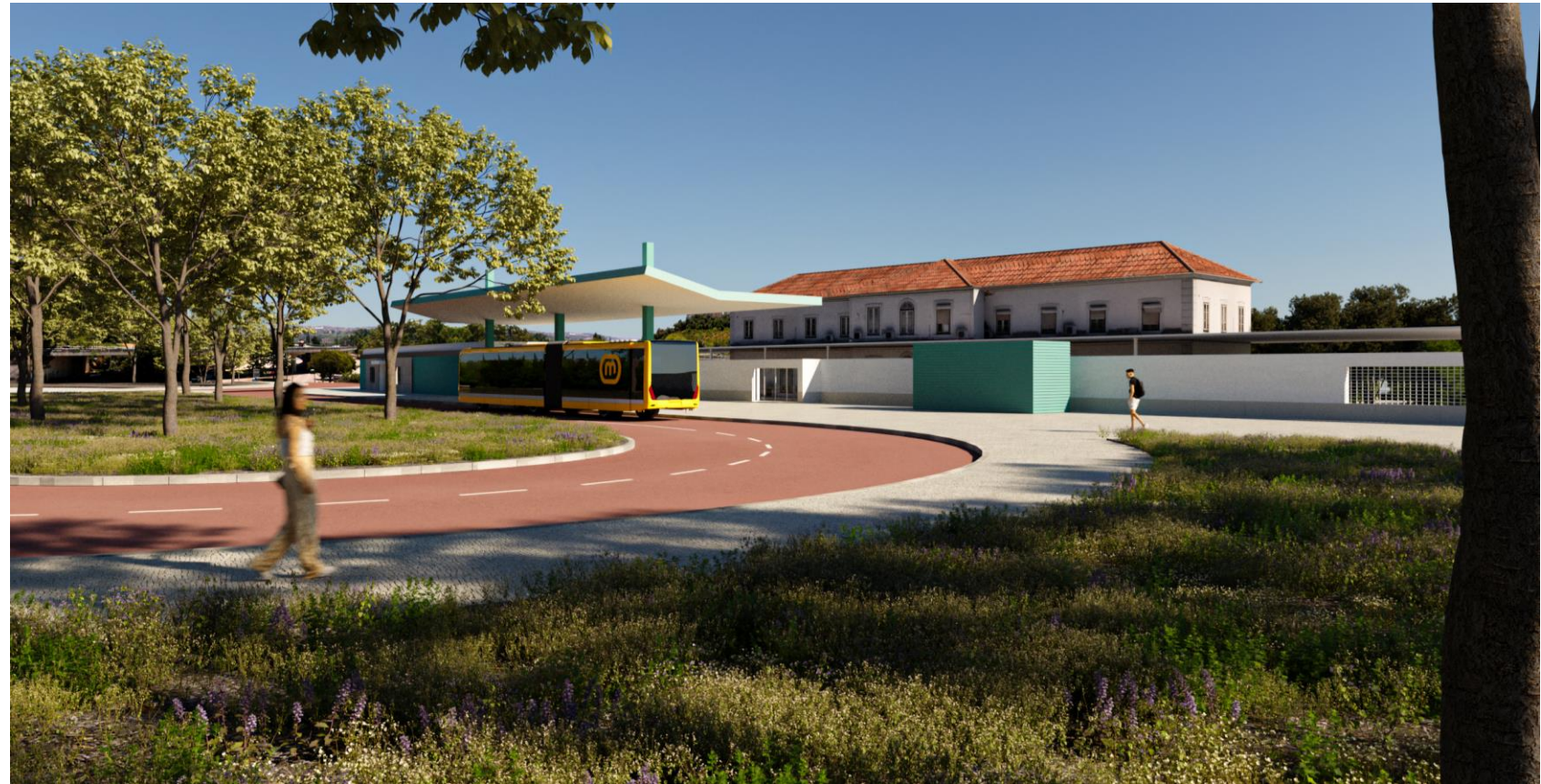
Estação Coimbra B
