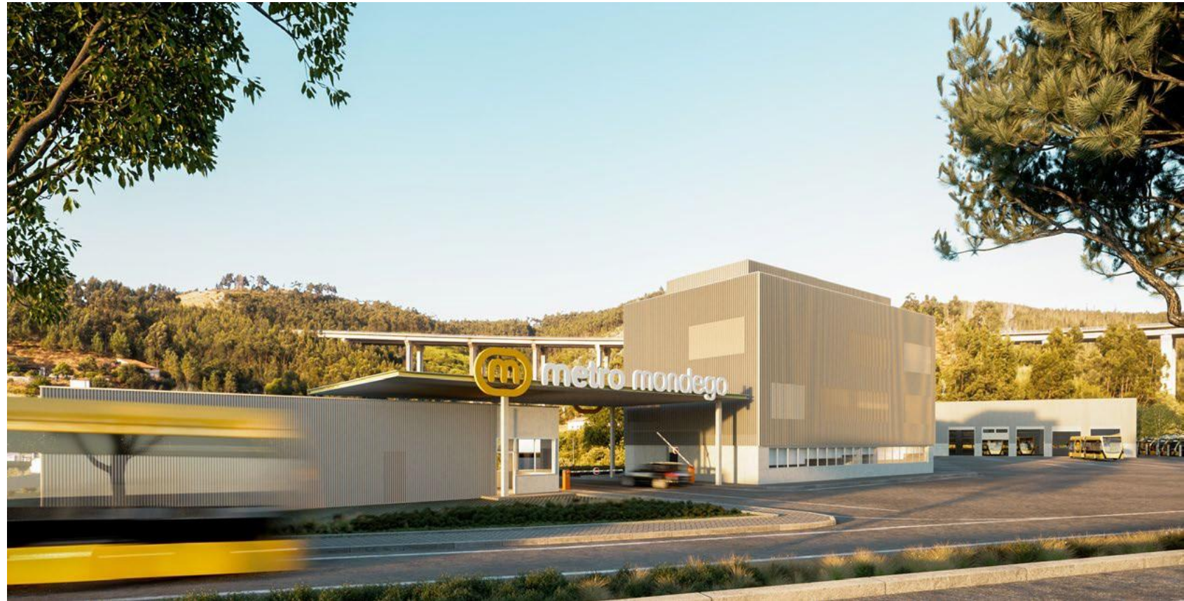
Parque de Material e Oficinas
