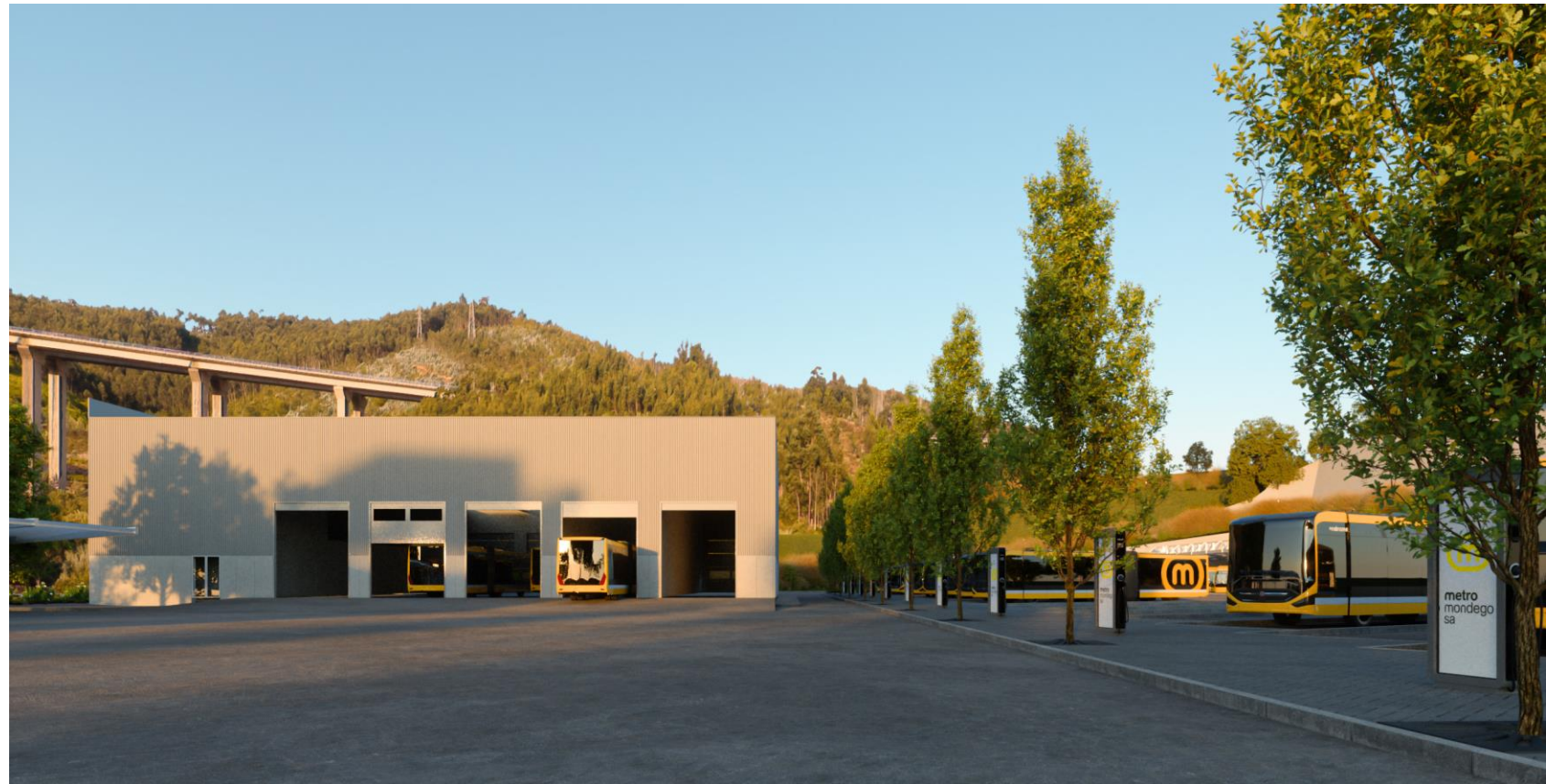
Parque de Material e Oficinas
